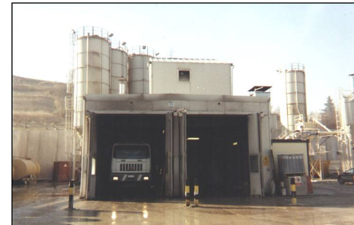
Figura 1/4.7.4.1.1.1 – Impianto di betonaggio insonorizzato
